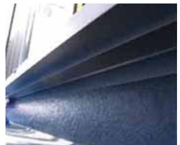
FRP防水先施工、サッシ後付けの施工例、バルコニーの立上がりは120mm以上確保する。
