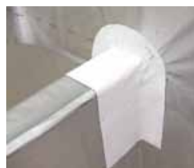
外壁と手すりの取り合い部の防水テープ
