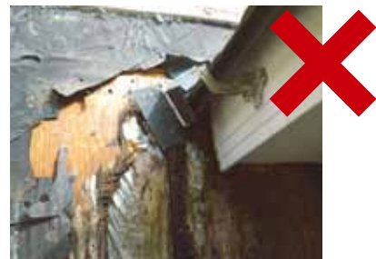
壁止まり防水処理が不適切だったため雨漏りしてしまった事例
