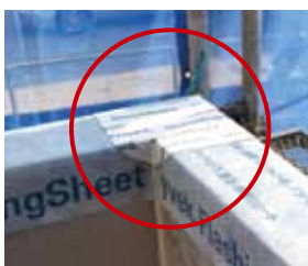
出隅部の三面交点の防水テープ
