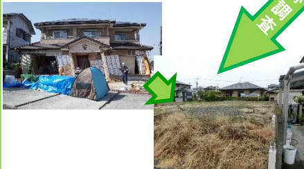
2018年熊本追跡調査 震災2年後の建物状況を調査・分析
