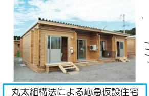
丸太組構法による応急仮設住宅
